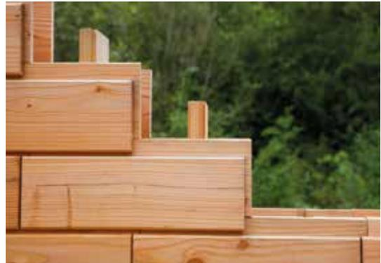
Après 10 ans de recherche et développement et 10 brevets, la brique en bois Brikawood a atteint la maturité technologique. Ce système sans clou, ni vis ni colle, se conçoit comme un jeu intuitif et logique. La brique est constituée de quatre éléments en bois, assemblés par un système d'emboîtement qui participe à la rigidité mécanique de l'ensemble.
